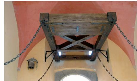
Le pont-levis est souvent le dernier ouvrage concerné dans la restauration d'un château. A la fois robuste et manœuvrable, ce dispositif de défense met en jeu l'expérience de nos charpentiers les plus chevronnés. Afin de garantir le parfait fonctionnement du mécanisme de levage, une exactitude rigoureuse est apportée à la réalisation du pont-levis ou de la passerelle, depuis la sélection scrupuleuse des bois jusqu'à sa mise en oeuvre.
