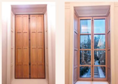
Volet intérieur traditionnel à cadre massif, avec panneau à plate-bande ou à glace à adapter selon vos projets. Mouluration petit-cadre à doucine. Ferrages et quincailleries montés et ajustés en atelier sur la menuiserie avec le plus grand soin.
